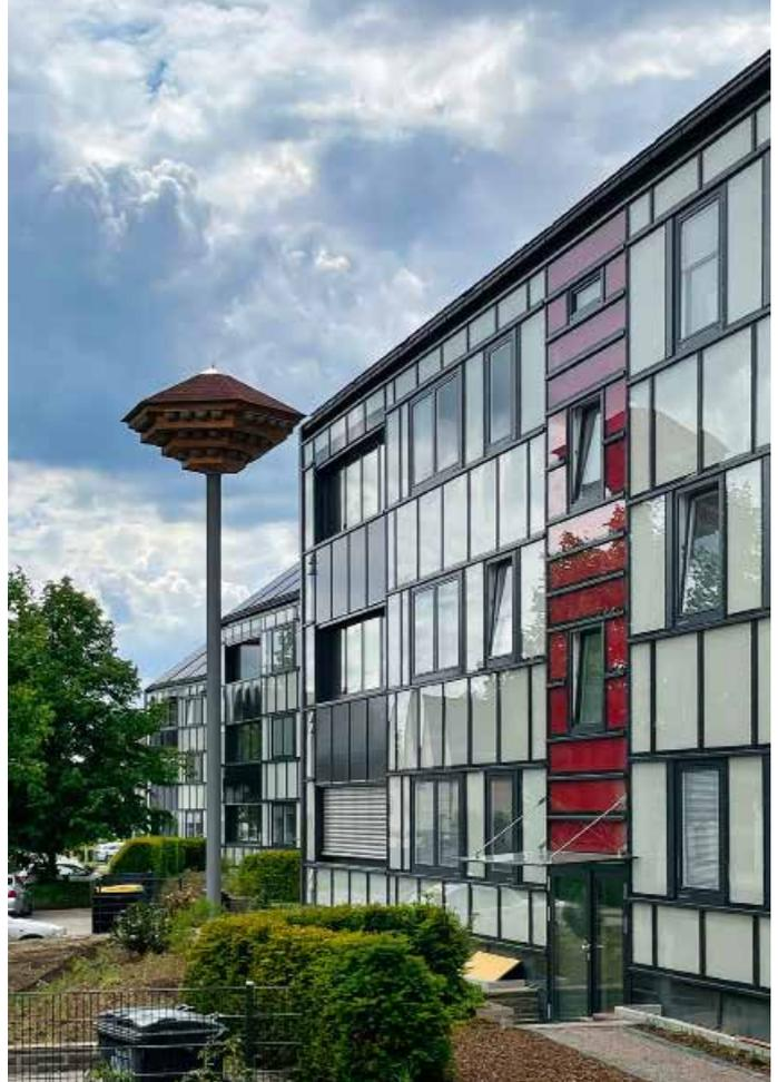
In der Ulmenstraße 5 realisierte die WWS 2021 ein Energiesprong-Pilotprojekt, um Net-Zero-Standard zu erreichen. Die benötigte Energie für Heizung, Warmwasser und Haushaltsstrom sollte durch das Gebäude selbst erzeugt werden. Durch die Ertüchtigung der Gebäudehülle, PV-Ausstattung, Infrarotheizung und elektrische Wasserheizung wurde der Bedarf um fast 90 % gesenkt
