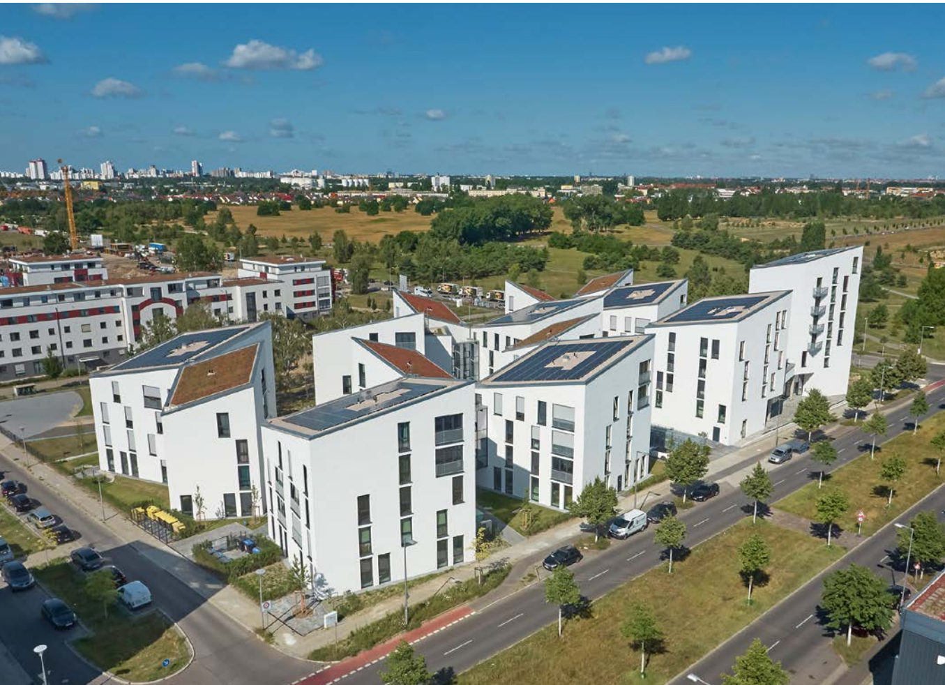
„Future Living Berlin“-Wohnanlage der GSW in Berlin-Adlershof: die PV-Anlage produziert Energie für die Luft-Wasser-Wärmepumpen und den günstigen Mieterstrom
