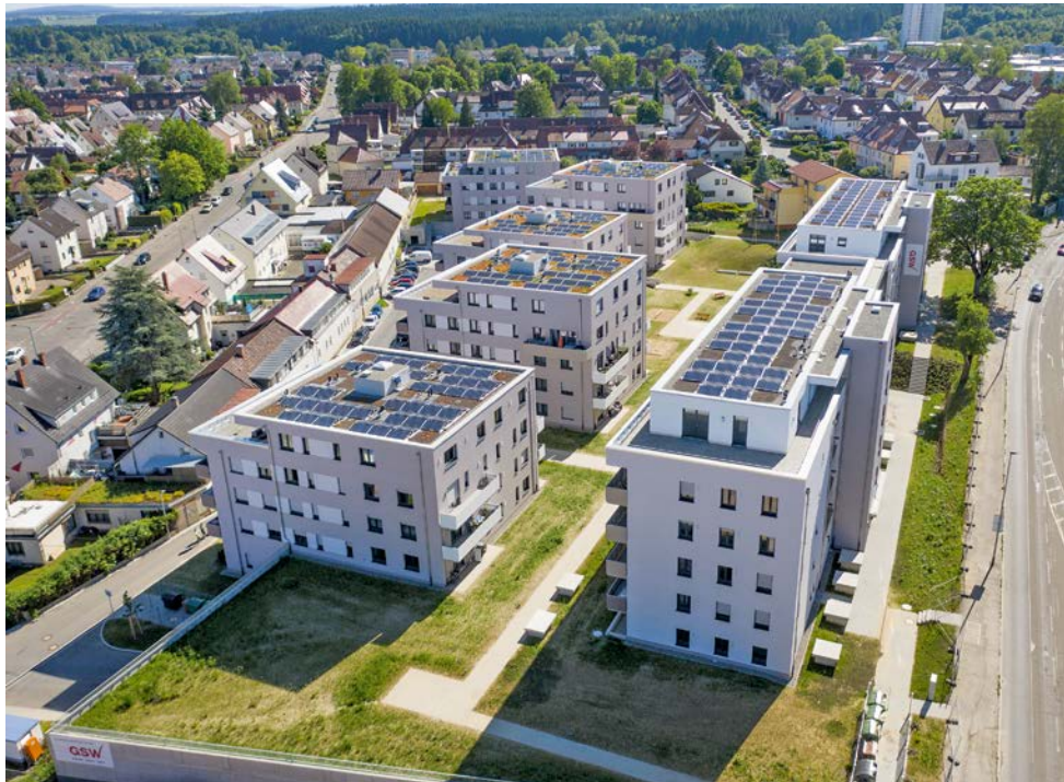
Wohnanlage mit 53 frei finanzierten und 103 öffentlich geförderten Mieteinheiten der GSW in Villingen-Schwenningen: die PV-Anlage auf den Dächern erzeugt günstigen Mieterstrom
